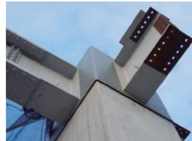
T-ReCS構法®の柱梁取合い
