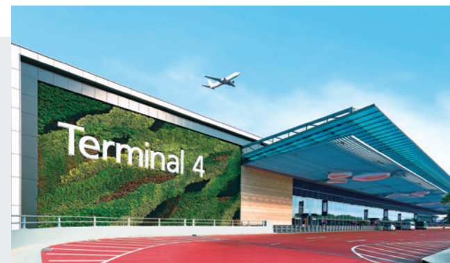
チャンギ空港 第4ターミナルビル (2017 シンガポール)
