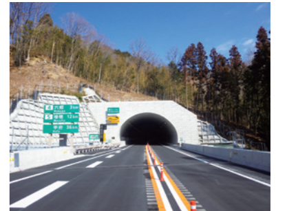
中部横断道 城山トンネル工事
