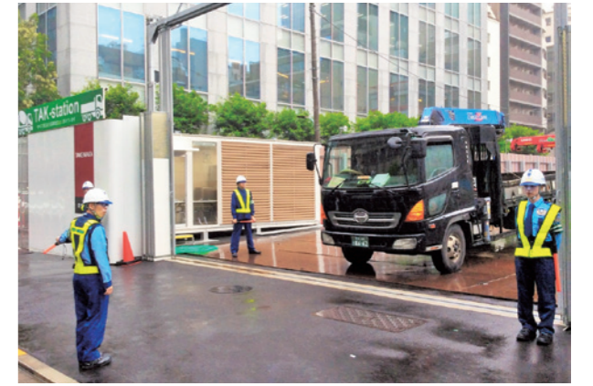
待機を終え「TAK-station」から出る搬入車両
