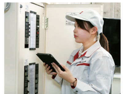
建築設備の日常点検
