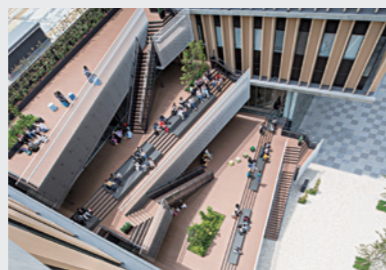
「ステップテラス」は学生の動線となるとともに、外部の緑や富士山への眺望による憩いの場所であり、建物内への通風も確保しています。
