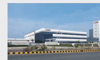
三菱電機エレベーター インド新工場 (2016 インド)
