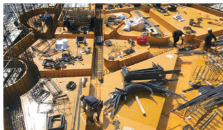
曲面により構成された複雑な躯体施工
