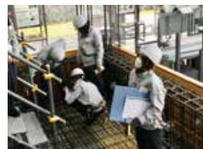
竹中技術実務研修センター「想」での配筋チェック実習
