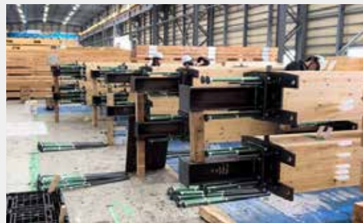
大阪・関西万博工事 場外ロジセンターでの事前組立て
