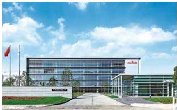
無錫村田電子有限公司第二工場 (2020 中国)
