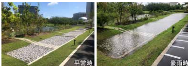
雨水貯留浸透技術レインスケープ®の効果実証の様子
