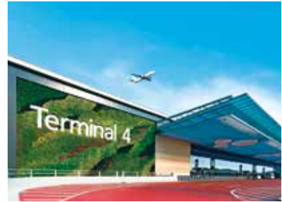
2017 チャンギ空港 第4ターミナルビル
