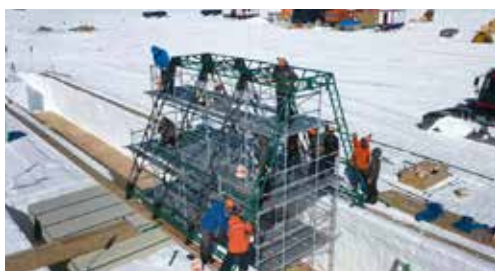
南極での軽量・高耐久建材組み立ての様子 (63次同行岩手日報記者撮影)
