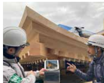
BIMデータと仕上がり状況を現地で確認
