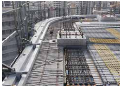
曲面バルコニーをハーフPCaとし、型枠作業を排除
