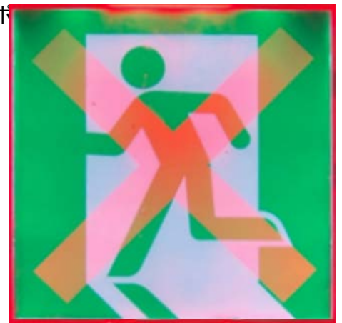
進入禁止を表示した避難口誘導灯
