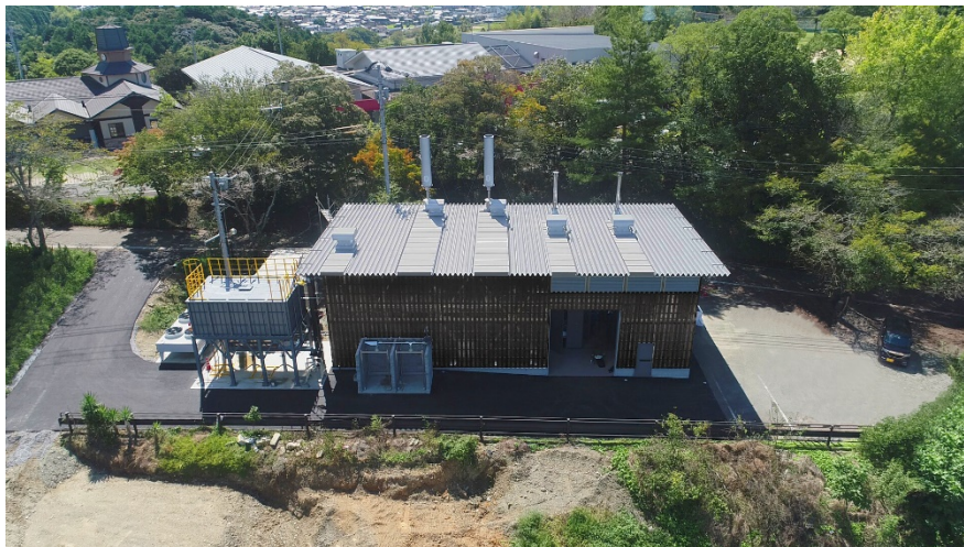
「内子龍王バイオマス発電所」外観
