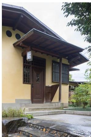
巨木化した樺の根の影響により、大きく変形・破損していた石段について、石をすべて取り外し、鉄筋コンクリートの基礎を新たに構築した後、同じ位置に戻して復旧しました。そのほか、木々に埋もれていた滝、池、小川の石組みと水盤を調査し、復原するとともに敷地全体の外構庭園整備を行いました。
