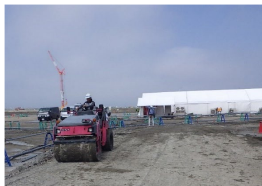
地盤改良の施工状況
