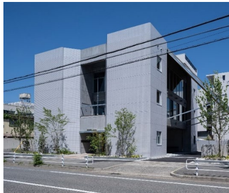
建物外観（竣工時）
