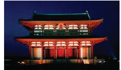
Photo 14 平城宮朱雀門（基壇に超高耐久性コンクリートを適用） Heijo-kyu Suzaku Gate (Super durable concrete was used for the base)
