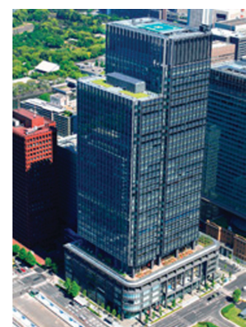
Photo 13 新丸の内ビル（コンクリート約10,000tをリサイクルし、1F、B1Fの一部に適用） Shin Marunouchi Building (10,000 tons of concrete was recycled)
