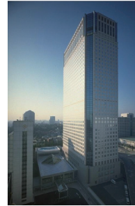
Photo 4 品川プリンスホテル新館 ( F_c=60\text{N/mm}^2 , 39F, CFT構造) Shinagawa Prince Hotel
