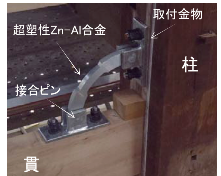
Photo 3 伝統木造建築用超塑性Zn-Al合金ダンパーの取付け状況例 Superplastic Zn-Al alloy seismic damper
