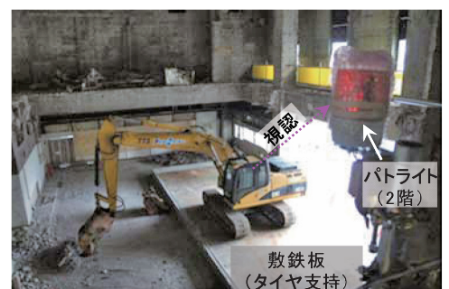
Photo 6 実証試験の実施状況 Situation of verification test
