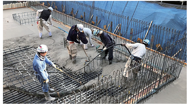
Photo 5 ECMコンクリートの適用状況 Application status of ECM concrete
